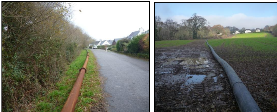
Photo 7 : Exemples de conduite de refoulement (en métal et en PEHD)
