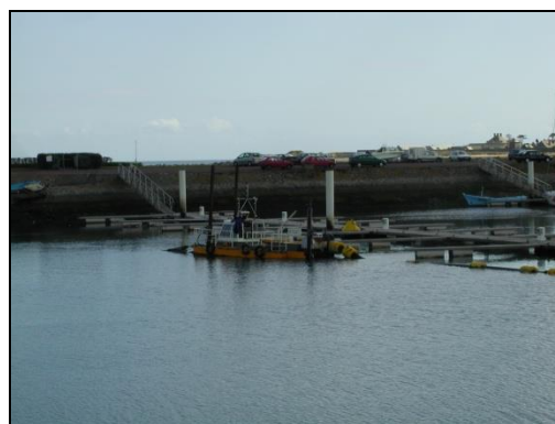
Photo 6 : Vue des pontons libérés des bateaux (source : MARC SA)
